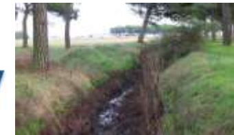
Canal de escorrentía procedente de Pedrajas
