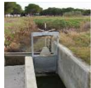
Punto de conexión
